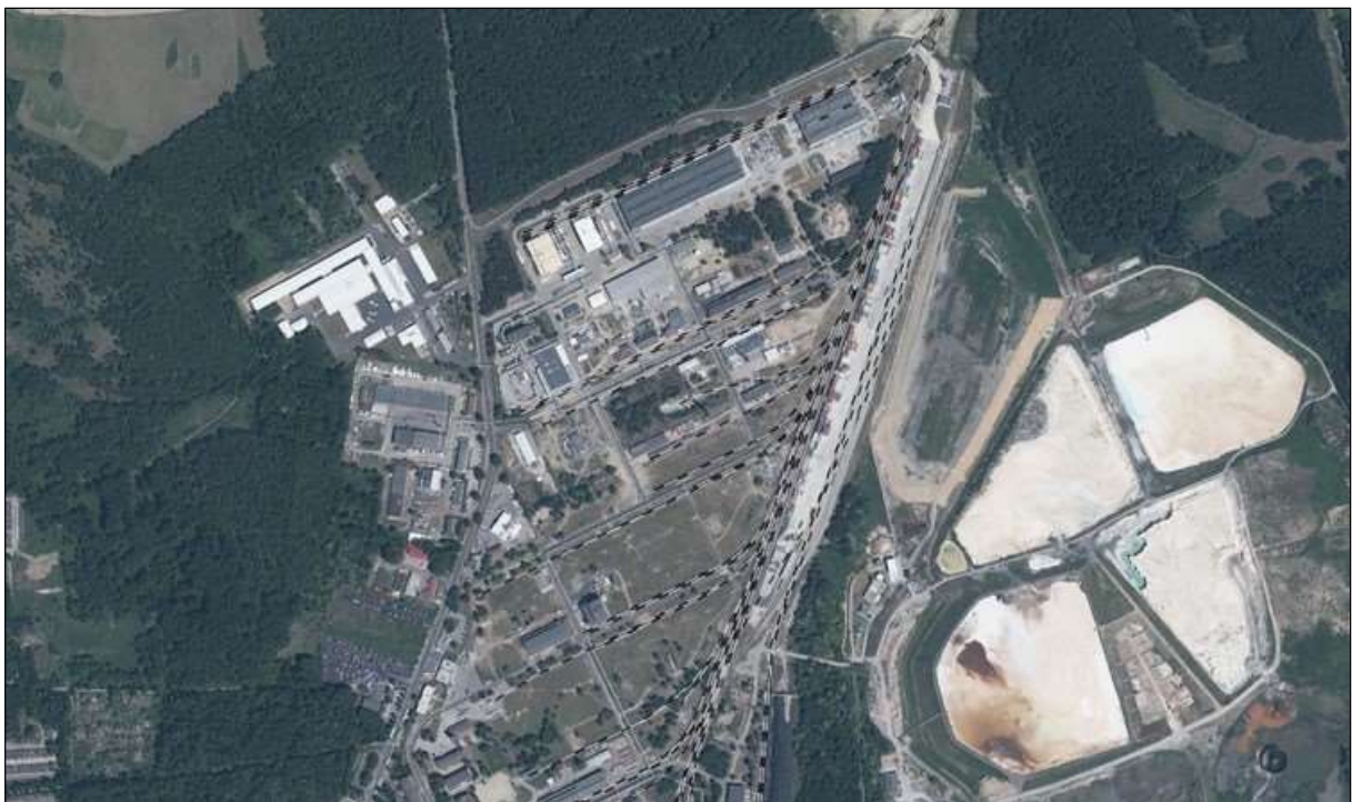
Abbildung 37: Terminal Brzeg Dolny 37
