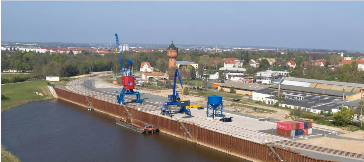
Abbildung 12: Hafen Torgau nach Abschluss der Modernisierungsmaßnahmen 36
